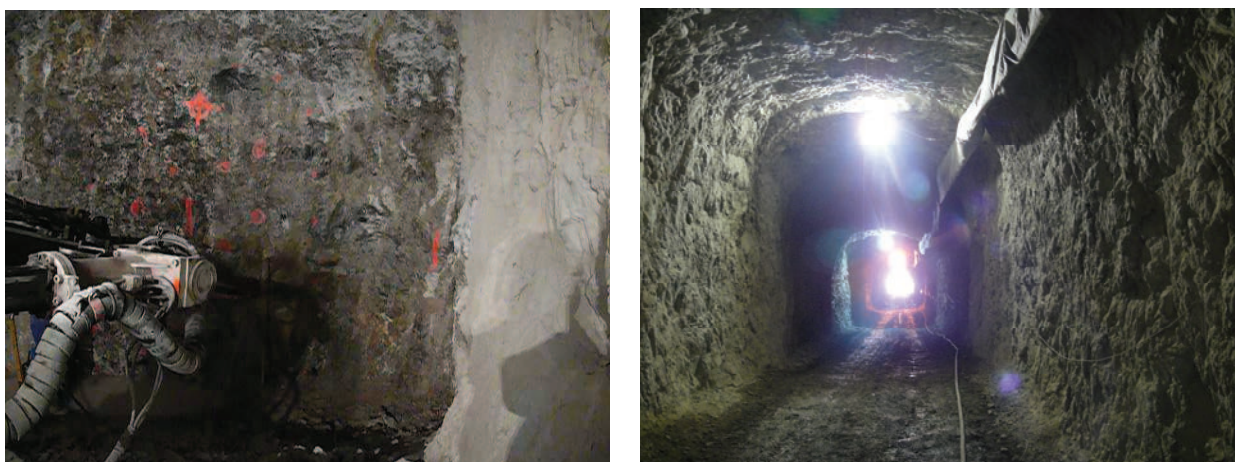
Figura 17. Preparazione alla volata e veduta della galleria
